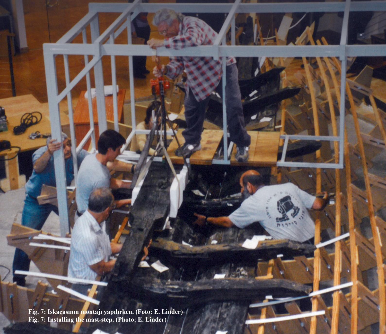
Fig. 7: Iskaçasının montajı yapılırken. (Foto: E. Linder)
