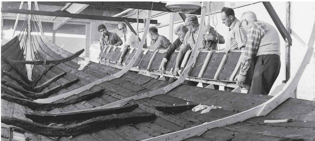
**Fig. 10:** Skuldelev 1'de borda kaplamalarının şekillendirilerek test-montajlarının yapılması. (Foto: Viking Gemi Müzesi-Roskilde)
