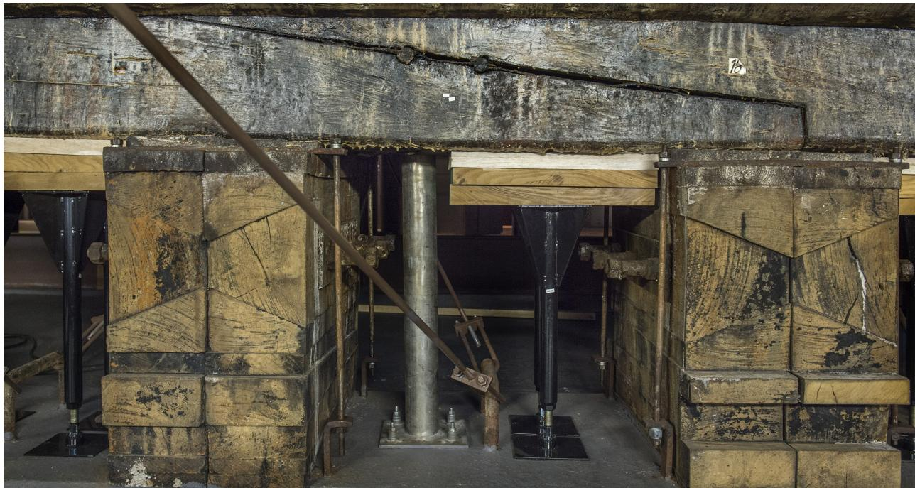
**Fig. 14:** Omurga bloklarının aralarına 1960'larda yerleştirilen ayarlanabilen çelik vida destekleri. Görülen diğer çelik kolon ana direğin ağırlığını taşıması amacıyla 1990'larda eklenmiştir.
