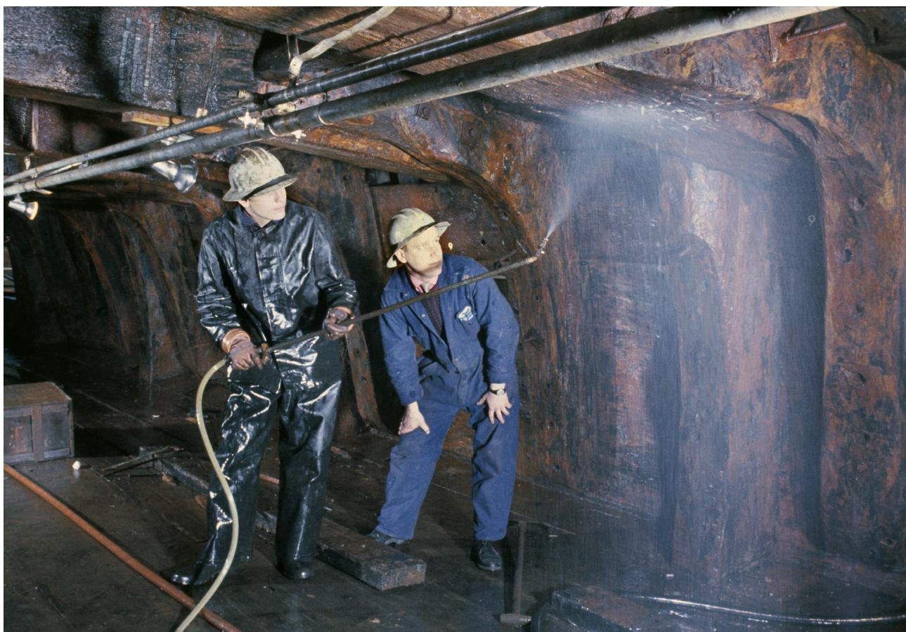
**Fig. 3:** 1965 yılında otomatik püskürme sistemi monte edilmeden önce gemiye elle püskürme uygulanıyor.
