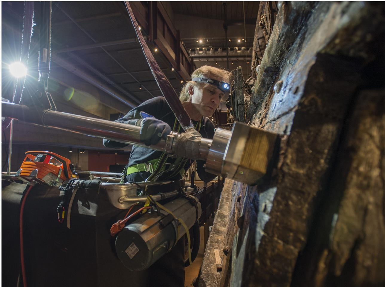
**Fig. 16:** Baş üstü vinçten asılmış özel bir sıkma aleti kullanarak civataların değiştirilmesi.
