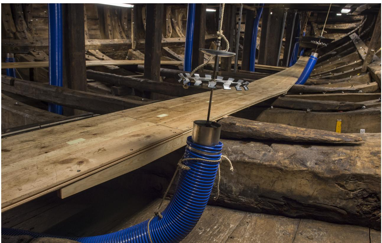
**Fig. 10:** Geminin içine monte edilen gelişmiş iklimlendirme çıkışları.
