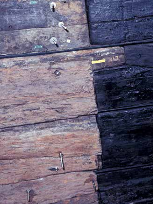
Fig. 22: Yeniden inşa edilmiş geminin pruva ve kıç arasındaki renk farklılıklarıyla çıplak gözle görünebilen testere kesikleri.
