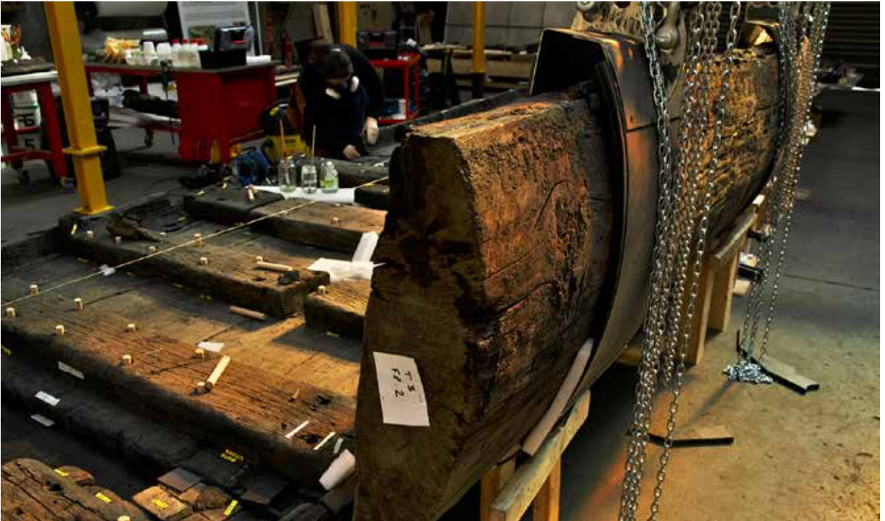
Fig. 20: Yarım gövde yan kaplamalarının ağırlıkları 200 ile 350 kg arasında değişmektedir. Doğru şekilde yönlendirilmeleri tekerlekli vinç ve makaralı zincirlerle mümkün olmuştur. (MDAA © Rémi Bénali)
