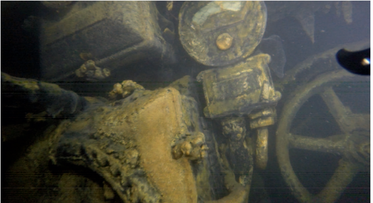
Fig. 10: Kontrol odasındaki safra pompası göstergelerinin ayrıntısı.
