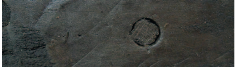
Fig. 9: Döşek alt yüzeyinde keser/balta izleri.
