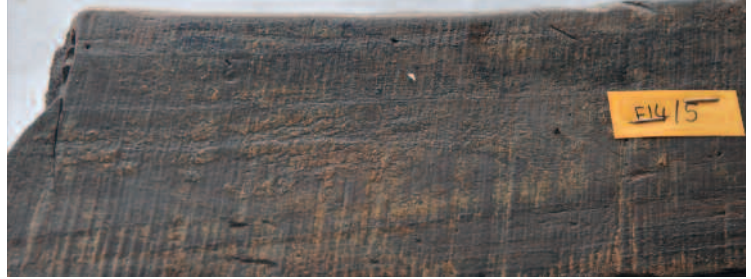
Fig. 8: Döşek üzerinde testere izleri.
