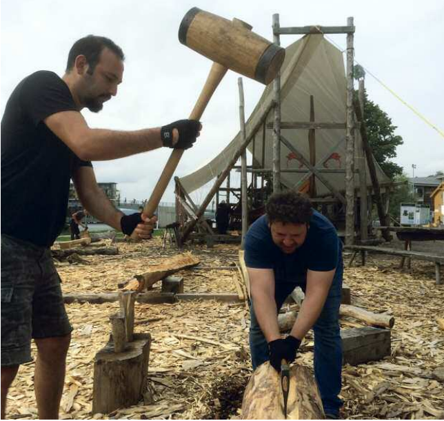
Fig. 2: Klastad Replika yapım çalışmaları Fig. 2: Shipbuilding Works of the Klaastad Replica
