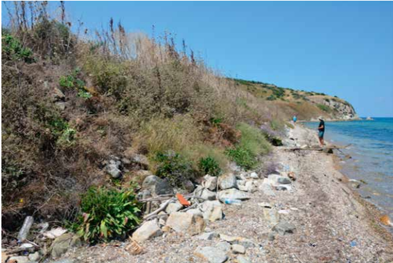
Fig.9: Kıyı Hattı Enerjisa Duvarlar.
