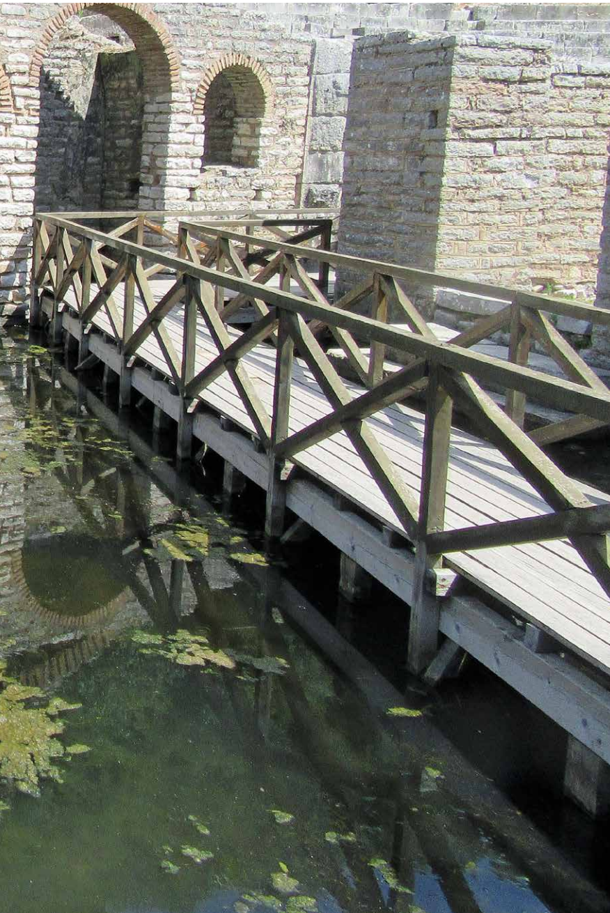
Fig. 1: Arnavutluk'un Butrint kentindeki Roma tiyatrosunun batık durumdaki girişi. Adriyatik kıyıların bu kısmı son ikibin yılda büyük depremler geçirmiştir. Taban seviyesi, neredeyse deniz seviyesiyle aynı bulunan yeraltı suyu seviyesinin yaklaşık 30 cm altındadır.
