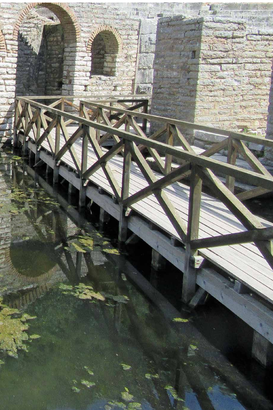
Fig. 1: Arnautluk'un Butrint kentindeki Roma tiyatrosunun batık durumdaki girişi. Adriyatik kıyıların bu kısmı son ikibin yılda büyük depremler geçirmiştir. Taban seviyesi, neredeyse deniz seviyesiyle aynı bulunan yeraltı suyu seviyesinin yaklaşık 30 cm altındadır.
