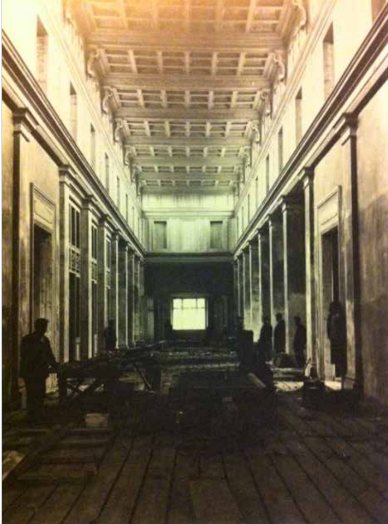
Resim 34: İmparatorluk Müzesi'nin yeni binasının yapımı (1891)
