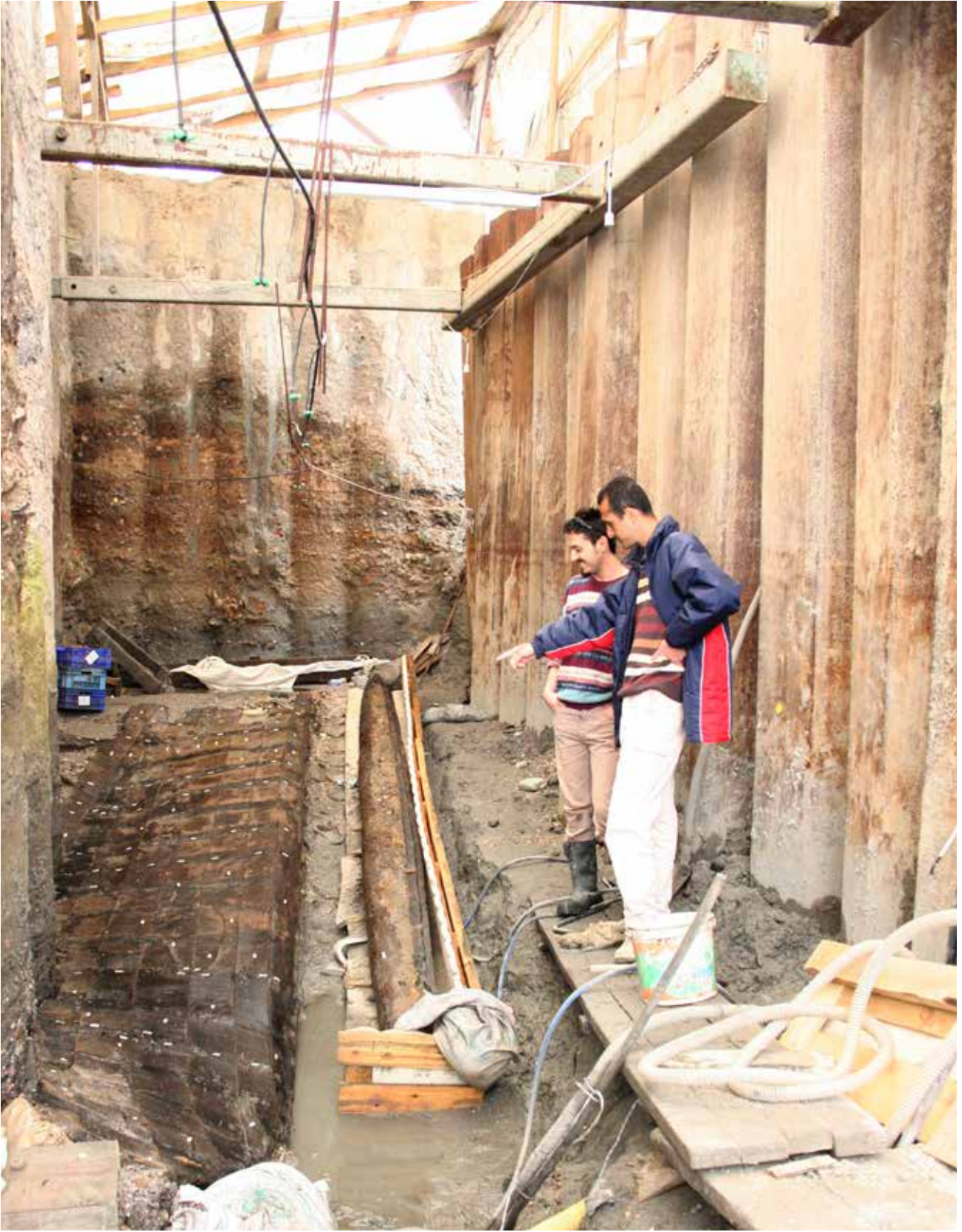
Fig. 3c: Yenikapı sahasından kalıplar üzerindeki ve köpük kaplı kutulardaki ahşapların çıkarılması (M. Jones/INA Arşivi). / Removal of timbers on molds and in foam-lined boxes from the Yenikapı site (M. Jones/INA Archive).
