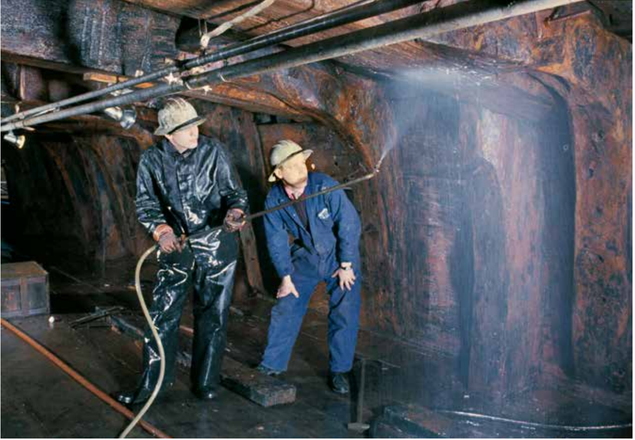
Fig. 3: 1965 yılında otomatik püskürtme sistemi monte edilmeden önce gemiye elle püskürtme uygulanıyor.
