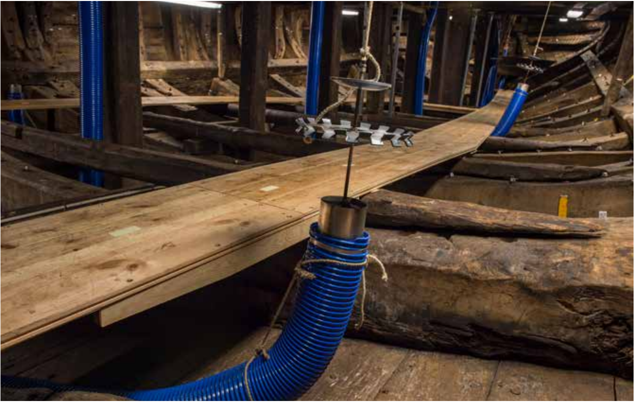
Fig. 10: Geminin içine monte edilen gelişmiş iklimlendirme çıkışları. Fig. 10: Improved climate control outlets inside the ship.
