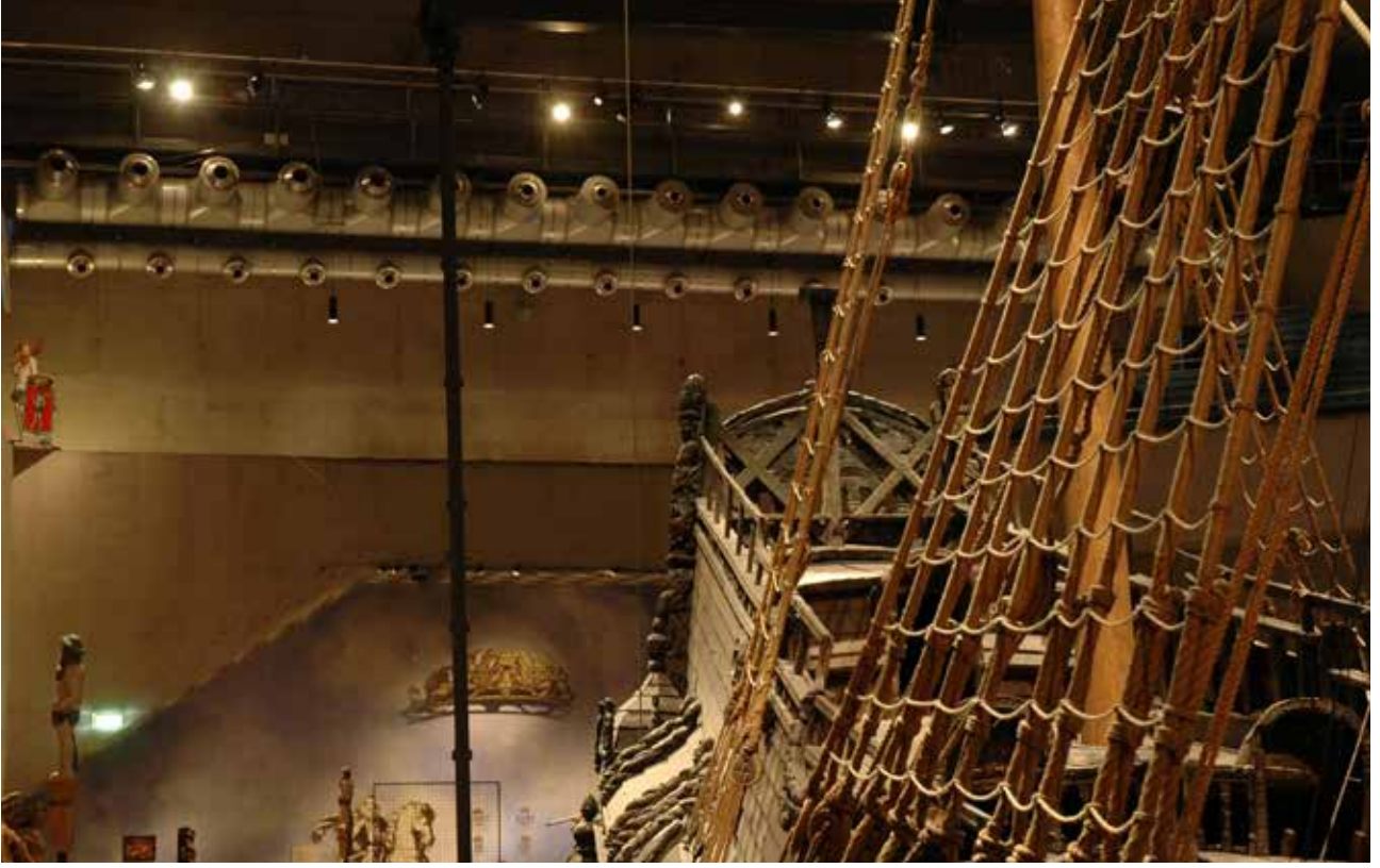
Fig. 9: 2004 yılında yenilenen sistemin bir parçası olarak eklenen iklimlendirme çıkışları geminin kıç bölgesinde görülüyor. Fig. 9: Extra climate-control outlets at the stern of the ship, added as part of the 2004 upgrade.
