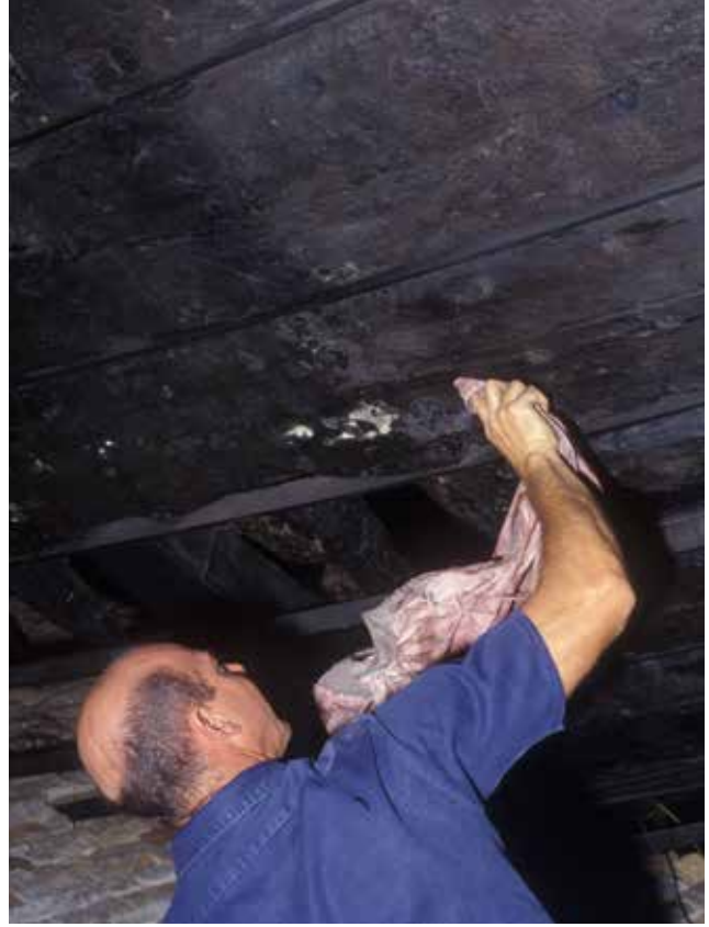
Fig. 23: Testere kesiklerine dolgu ile ahşapların renk uyumu için pigmentli PEG 3350'nin uygulanması.
